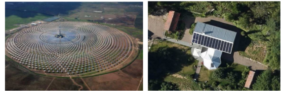
Figur 2: Solcellsinstallationer i Almeria och i Sverige.
