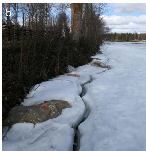
Figur 34. Exempel på naturliga erosionskydd i form av stenblock som lags ut i Umeälven. a) Bakom stenarna har sediment börjat samlas och en ny strand är på väg att byggas upp. b) Brottet i isen som uppkommer på grund av korttidsregleringseffekter hamnar utanför stenskydden och skonar strandkanten från isnötning. Foto Åsa Widén
