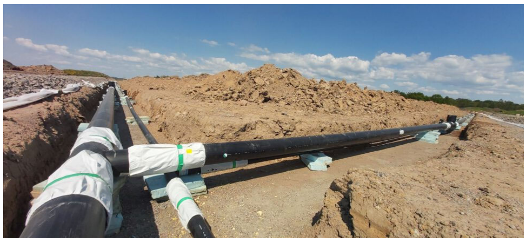
Figur 5. Anläggning av ledningsnätet sommaren 2020 med den mindre cirkulationsledningen till höger om den större twinledningen med både fram- och returledningarna.
