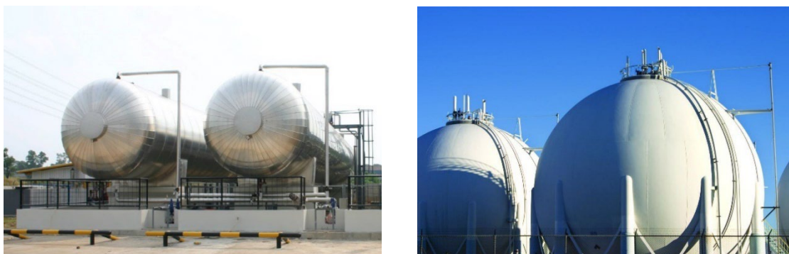
Figur 27 Till vänster ses exempel på cylindriska tankar för flytande koldioxid. Den högra bilden visar exempel på sfäriska tankar.
