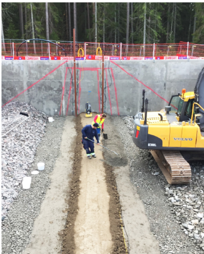
Figur 2: Byggande av dammen. Sett från höger anslutning.
