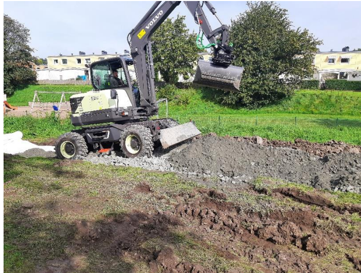
Figur 22 – Prototyhjulgrävaren bygger cykel- och gångväg.
