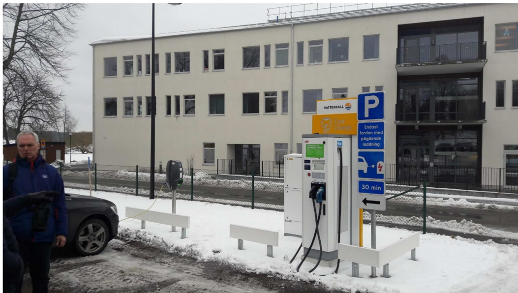
Bild 7 Laddstation med tillhörande parkeringsskylt
