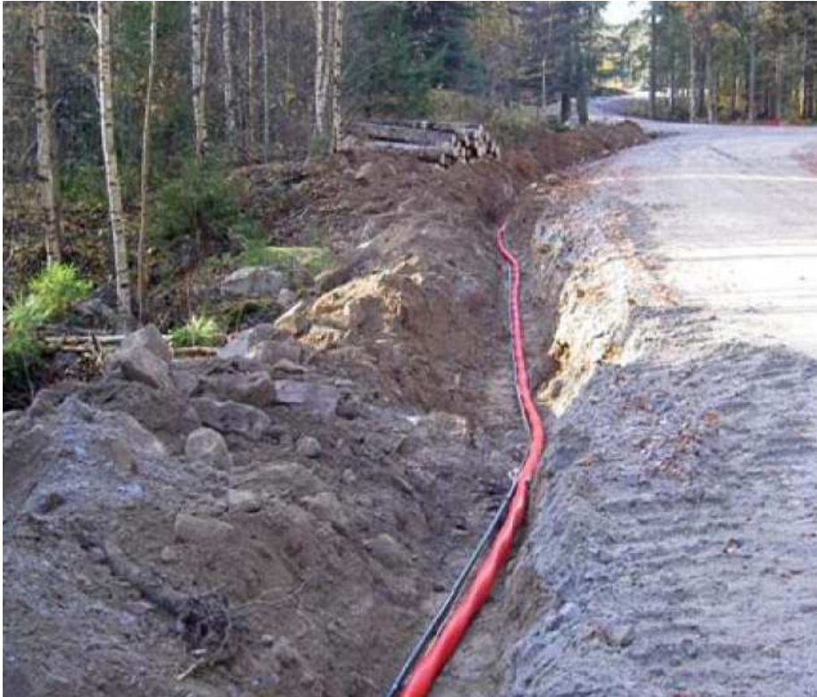
Bild 2: Kabelförläggning intill ny väg
