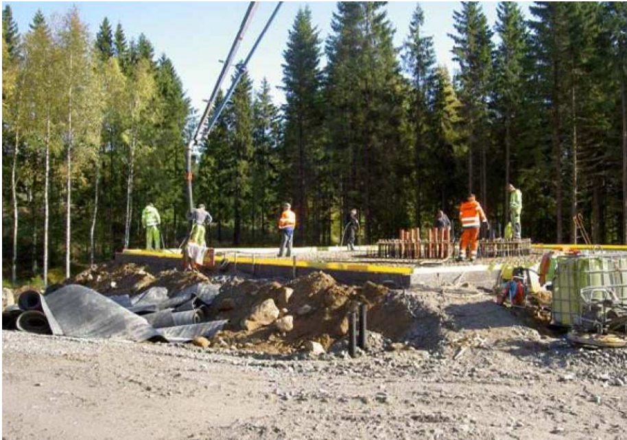
Bild 3: Gjutning fundament
