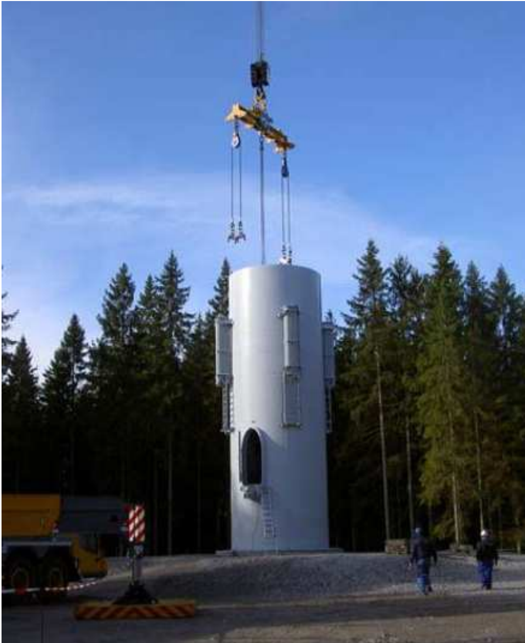
Bild 4: Montage bottensektionen
