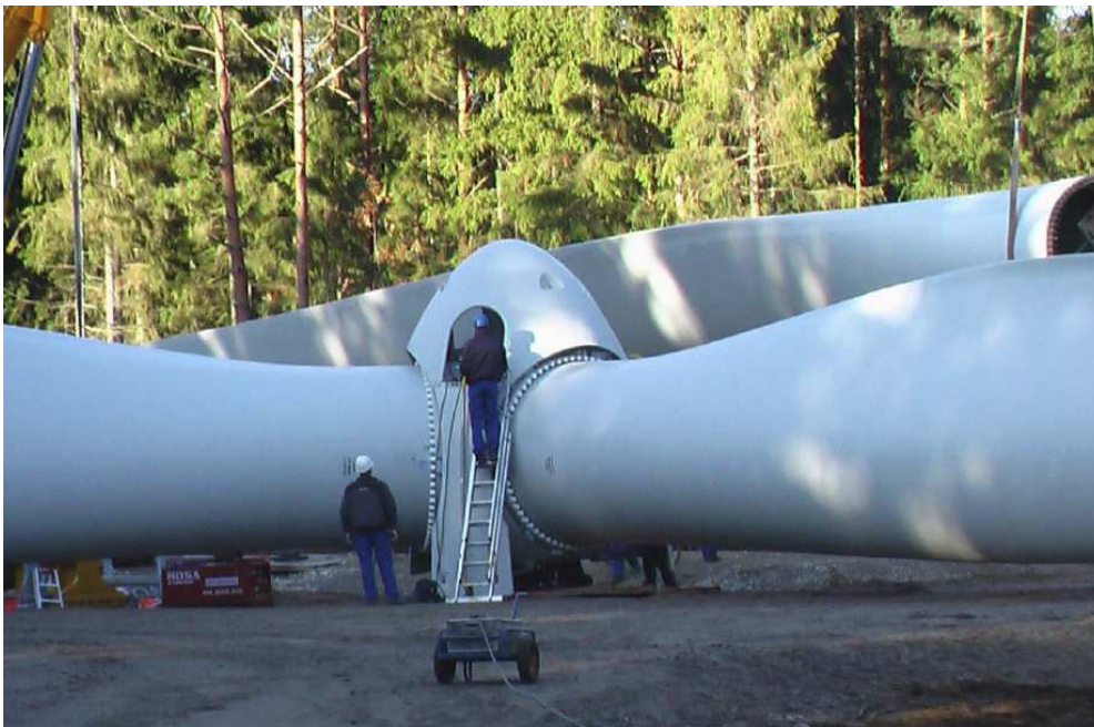
Bild 6: Vingarna lyftes monterade
