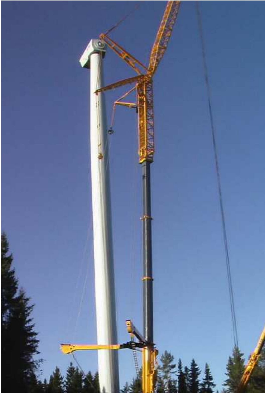
Bild 7: Montage nacell
