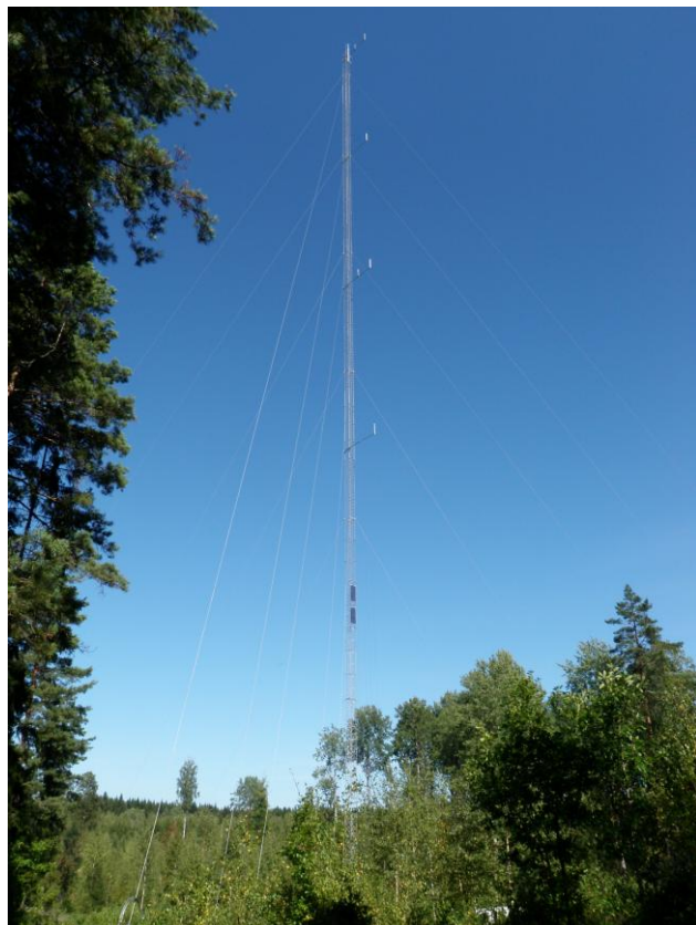
Figur 7: 100m, k600 mast med 4 mäthöjder.
